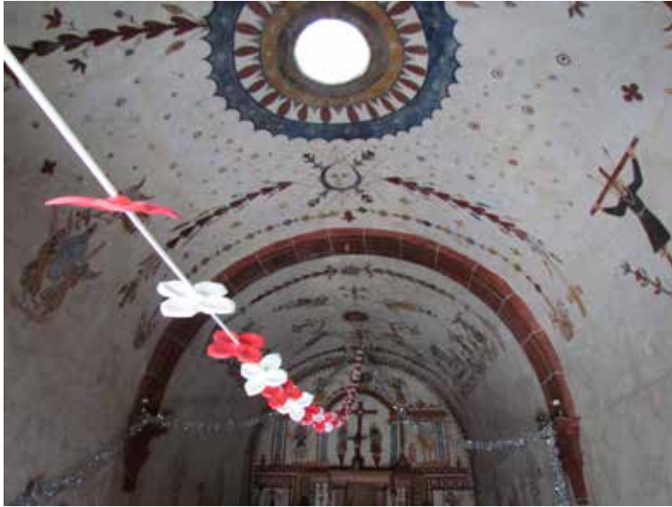
Fig. 14. Capilla de los Luna, San Miguel Tolimán, Querétaro, vista general de la bóveda. Viendo hacia el altar. Foto Isela Peña.
